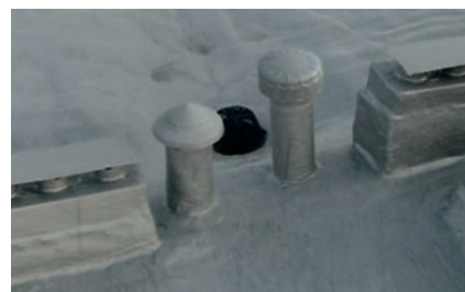
Dachdurchdringungen unterschiedlicher Art
