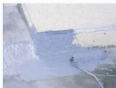
2. Nanést silnou vrstvu jako lůžko pro vlísovou vložku
