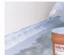
4. Válečkem nanést horní krycí vrstvu ... a je hotovo!
