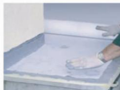
3. Vložit a zatlačit vlísovou vložku
