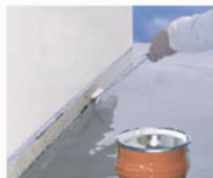
1. Válečkem nanést penetrační nátěr
