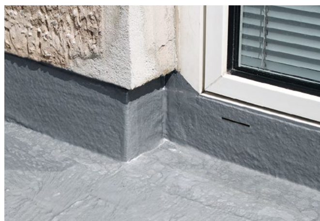
Remates laterales en paramentos verticales de poca altura, esquinas interiores y exteriores
