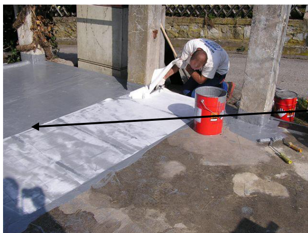
Polaganje filca na stik ali alternativno kot prekrivanje!
