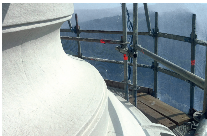
Zatesnitev spomeniško zaščitene zgradbe
