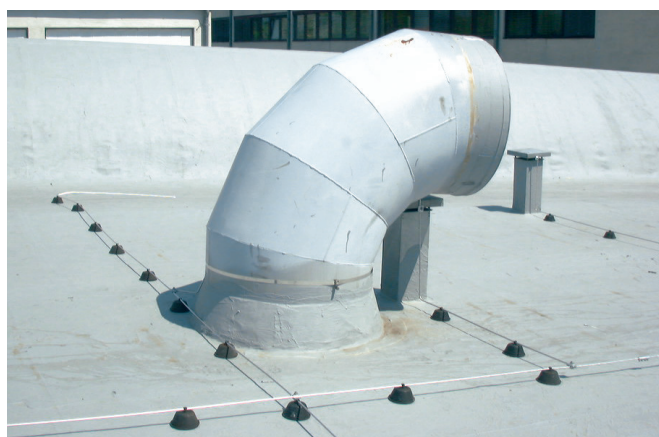
Priključki sten in preboji streh
