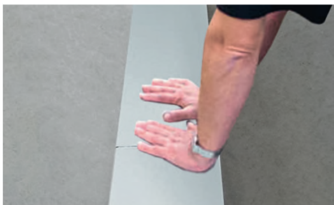
Pločevino pritisniti
