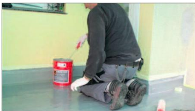
Nousevien seinäaluiden ENKETOP-pinnoittaminen
