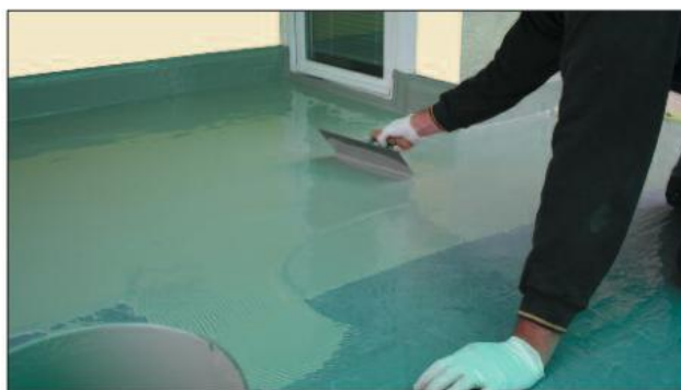
Yhdemukainen ENKETOP-pinnoittaminen hammastetulla tasoitustelalla
