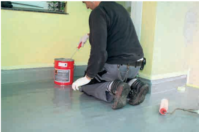
Seinäliitosten pinnoitus Enketopilla
