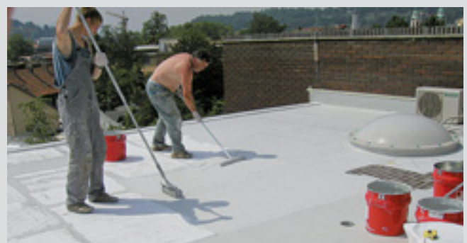
Die Dachfläche erhielt eine Abdichtung aus Enkryl.
