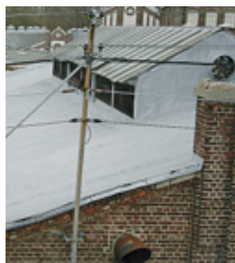
... sind auch 20 Jahre nach der Sanierung noch in einwandfreiem Zustand.
