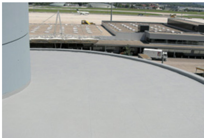
... und fertiges Parkdeck nach dem Auftragen von Enkryl.
