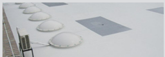
Auch Dachdurchbrüche wurden professionell abgedichtet.
