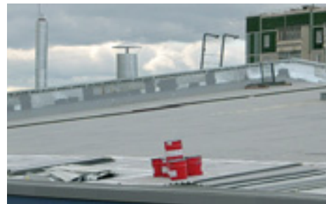
... mit dem Sanierungssystem von Enke.
