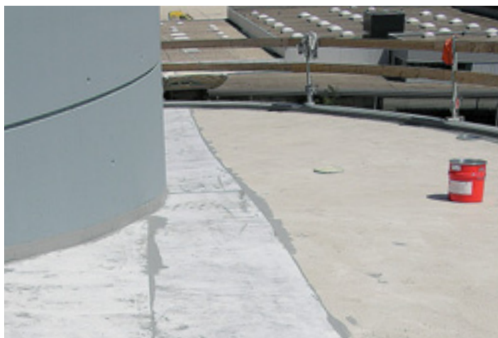
Verlegen der Polyflexvlies-Einlage ...
