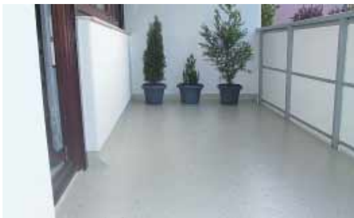
Saubere Arbeit: Mit dem cleveren System Enke BETONCOAT PMMA können Sie Balkone innerhalb eines Tages komplett sanieren.
