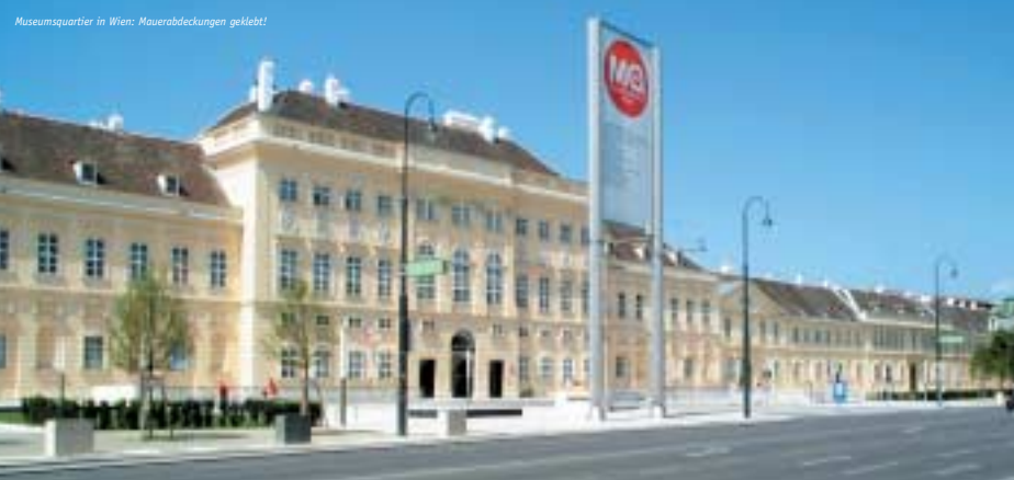
Museumsquartier in Wien: Mauerabdeckungen geklebt!
