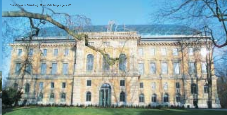
Ständehaus in Düsseldorf: Mauerabdeckungen geklebt!
