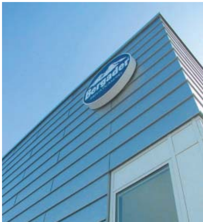
Mit ENKOLIT geklebt: eine neue Edelstahl-Fassade für die Privatkäserei Bergader.
