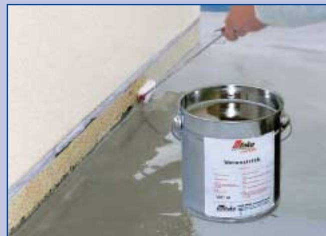
1. Voranstrich für bessere Haftung auftragen.
