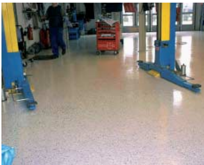
Attraktiv und belastbar: Enke-Betoncoat-Böden
