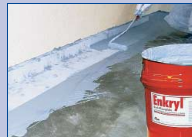
4. Deckschrift satt aufbringen.
