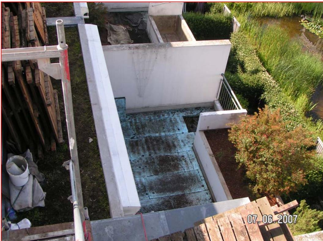
Abbau des vorhandenen Belages und bauseitige Lagerung
