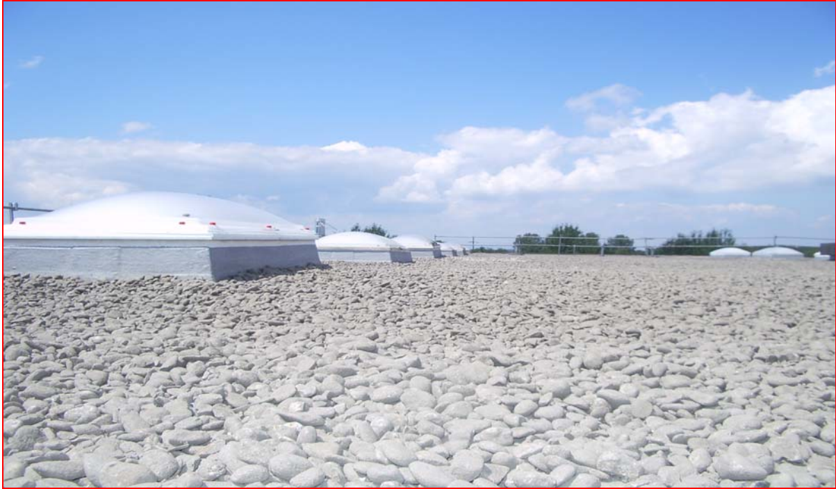
Dachlandschaft nach abgeschlossener Sanierung
