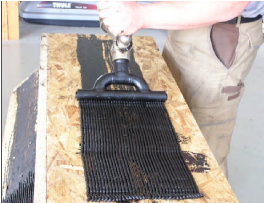
Verarbeitung von Enkolit mit dem druckluftbetriebenen Spritzenfüller DS 6
