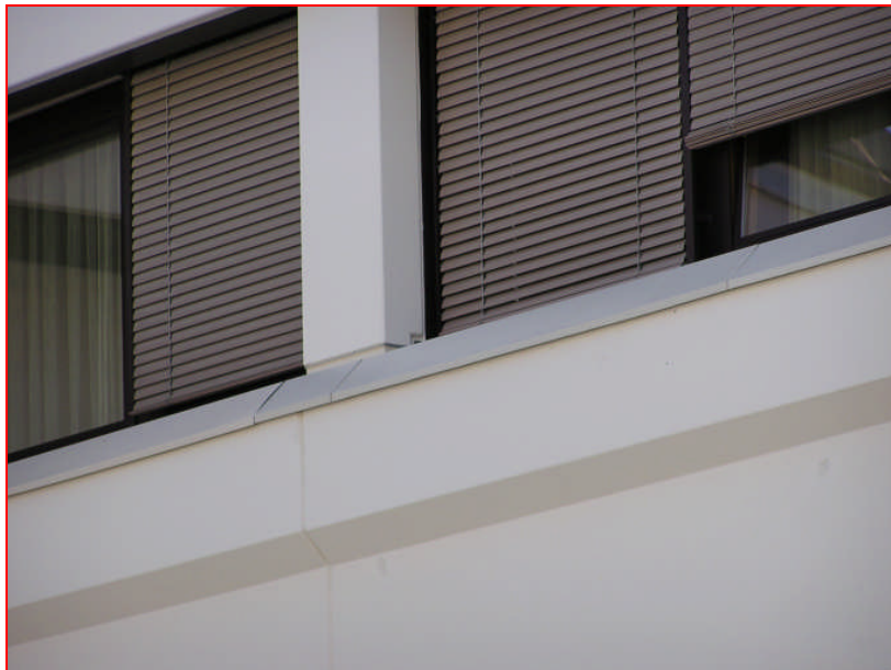
Ausführung des Dehnungsausgleichs über ein Nahtunterblech
