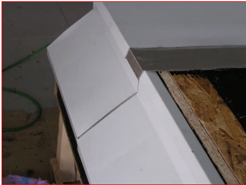
Ausführung des Dehnungsausgleichs über ein Nahtunterblech
