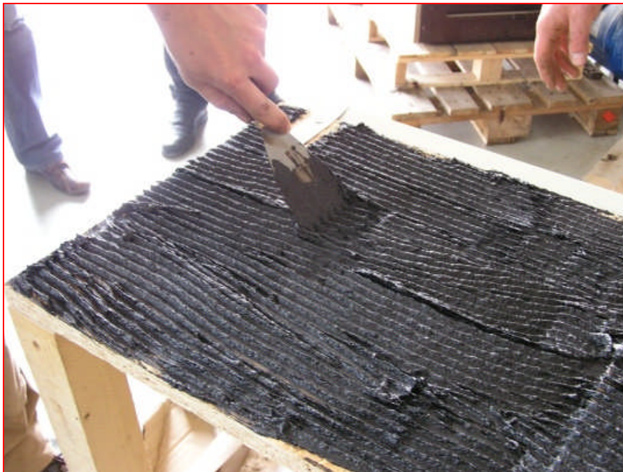
Verarbeitung von Enkolit mit dem Enke – Rillenspachtel
