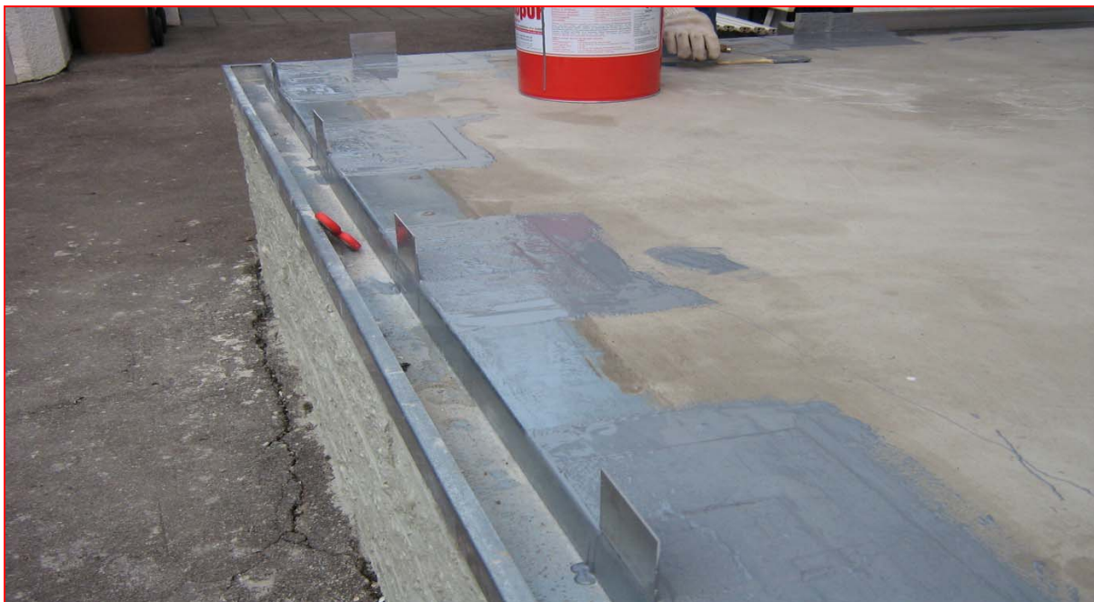
Anarbeiten der Details (Kiesleistenhalter)
