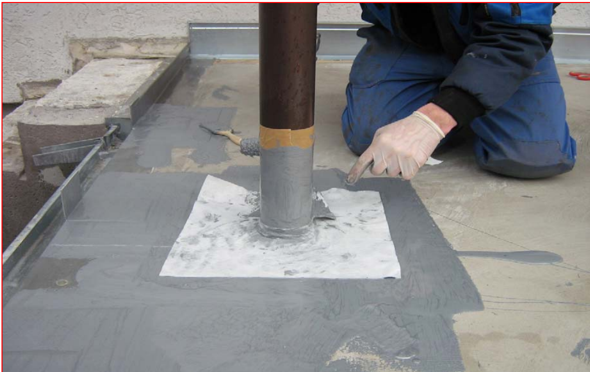
Eindichten der Rohrdurchführungen
