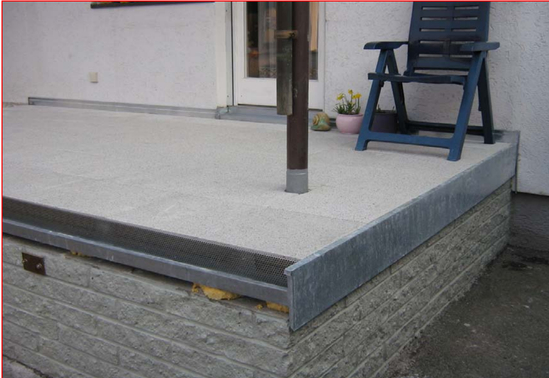
Fertige Terrasse mit Waschbetonplatten
