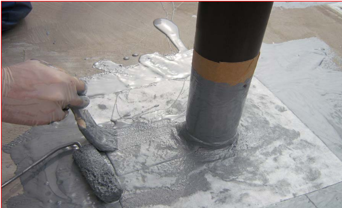
Aufbringen der Deckschicht aus Enkopur (bei kleinen Details zweckmäßigerweise mit einem Pinsel und kleiner Lammfellrolle)
