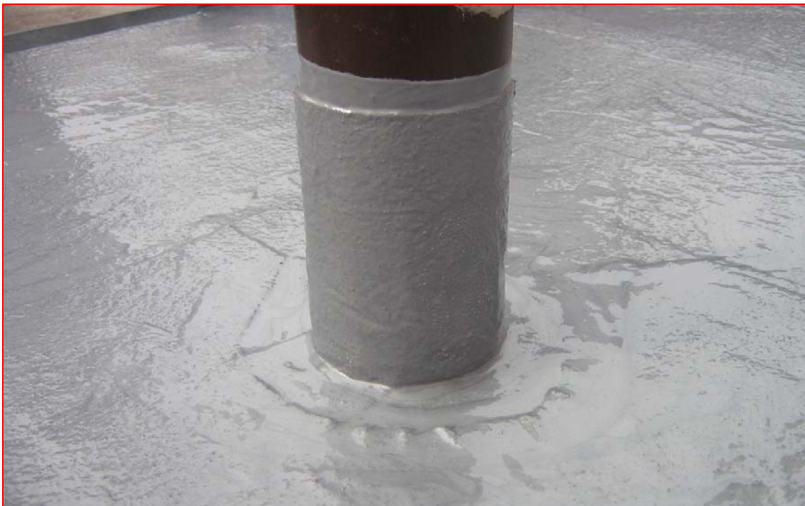
Aufbringen der Deckschicht aus Enkopur (bei kleinen Details zweckmäßigerweise mit einem Pinsel und kleiner Lammfellrolle)
