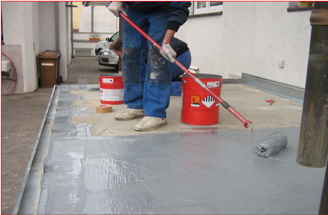
Aufbringen der Flächenabdichtung mittels Lammfellrolle
