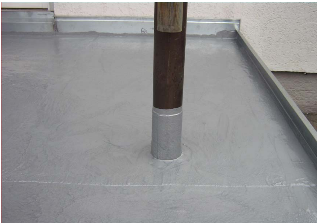
Aufbringen der Flächenabdichtung mittels Lammfellrolle
