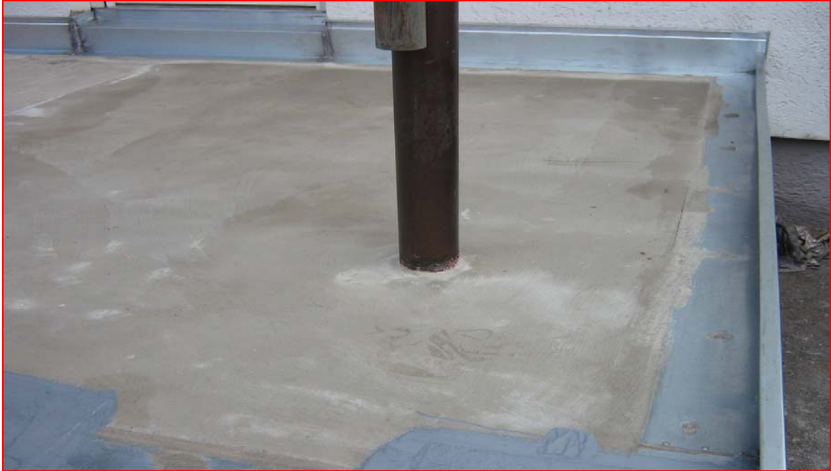
Eindichten der Rohrdurchführungen
