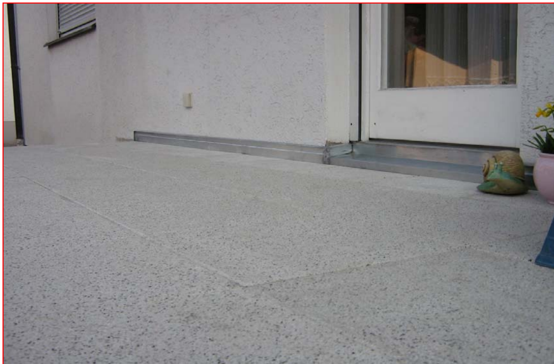
Fertige Terrasse mit Waschbetonplatten
