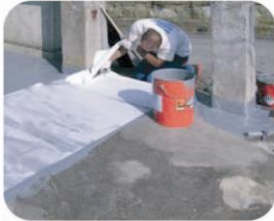
Nałożenie pierwszej warstwy ENKOPUR wraz z ułożeniem włókniny ENKE-POLYFLEXVLIES
