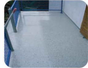
Gotowy balkon – powłoka ENKETOP i warstwa nawierzchniowa VERSIEGELUNG 1K
