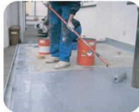
Nałożenie warstwy nawierzchniowej ENKOPUR
