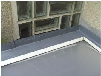
Die vollflächige Vlieseinlage ist dabei entscheidend für den dauerhaften Erfolg der Abdichtung. Wichtig ist auch die hohe Wasserdampfdurchlässigkeit des Materials, die langsam - aber langzeitsicher – für die Trocknung des bestehenden Aufbaues sorgt.
