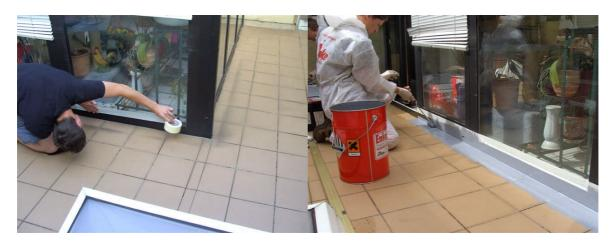
Auf die Glasbausteine wurde Enke – Glasprimer aufgebracht. Dieser Voranstrich erzielt auch auf den keramischen Fliesen die besten Haftungswerte. Nach nur einer halben Stunde Ablüftzeit wurde Enkopur vollflächig vorgelegt. In die noch feuchte Beschichtung wurde dann Enke - Polyflexvlies mit 6 bis 8 cm Nahtüberdeckung eingelegt und mit einer Veloursrolle angedrückt. Mit Einlegen des Vlieses konnten sämtliche Anschlüsse problemlos abgedichtet werden. Zum Schluss wurde die Deckschicht aufgebracht.
